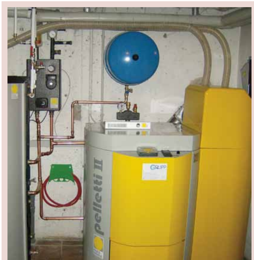
Die Firma Frank Grupp hat schon viele Jahre Erfahrung mit Pelletheizungen. Über 100 solcher Anlagen wurden von ihr seit 2002 geplant und gebaut. Die Vorzüge liegen für Firmenchef Frank Grupp auf der Hand: Pellets sind umweltfreundlich, der Preis für Pellets obliegt nicht politischen Einflüssen und der Stadt fördert den Einbau von Pelletheizungen, die kinderleicht zu bedienen sind. Firmenfoto
